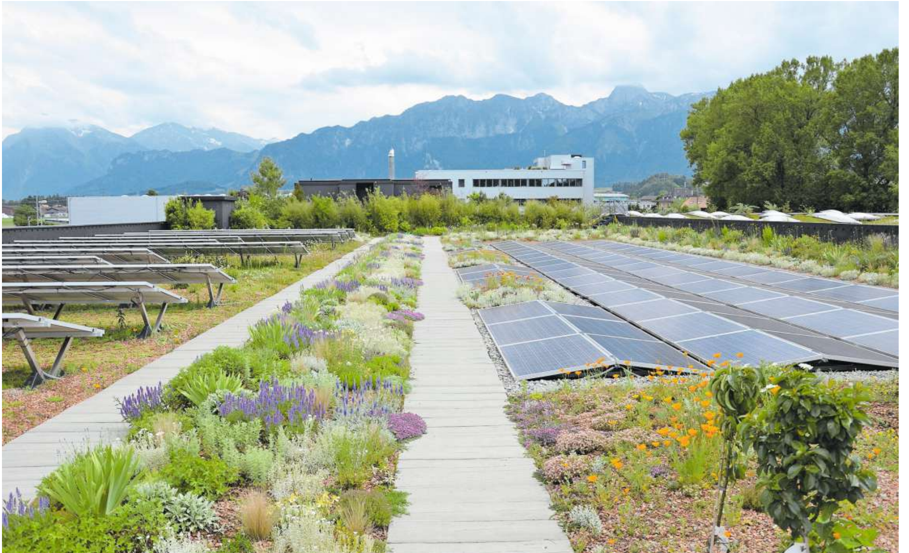
Silberlaubige Vegetation und PV-Module auf dem Dach der Firma Contec in Uetendorf BE.
