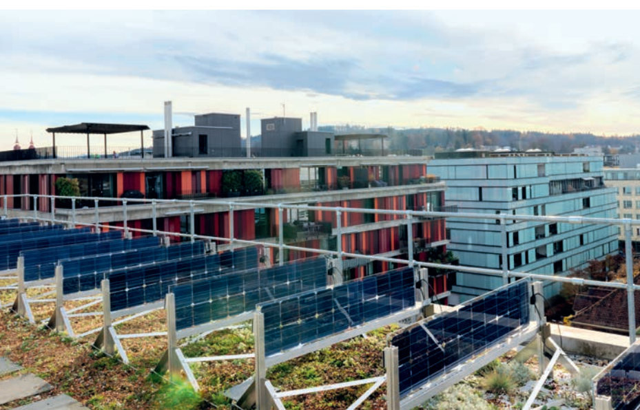
Mehr Platz für die Natur: Die Pilotanlage der ZHAW in Winterthur setzt auf vertikal montierte doppelseitige PV-Module. Foto: ZHAW
