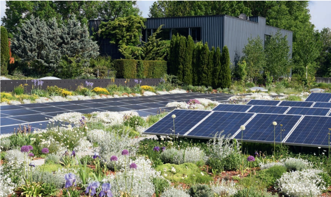
Das Energiegründach kombiniert die wertvollen ökologischen Vorteile begrünter Dächer mit der Solarstromproduktion.
