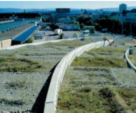
Versuchsdachbegrünung: Kiesig-sandige Substrate mit verschiedenen Überdeckungsvarianten werden bezüglich ihrer unterschiedlichen Entwicklung untersucht. (Foto Stephan Brenneisen)
