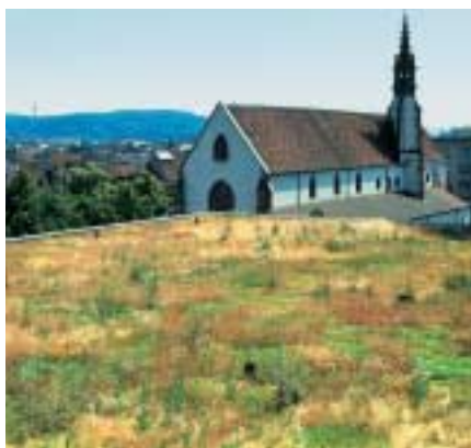
Wichtige stadtökologische Vorteile begrünter Dächer sind die ästhetische Wirkung als Grünfläche sowie die Wasserrückhaltung. (Foto Pia Zanetti)
