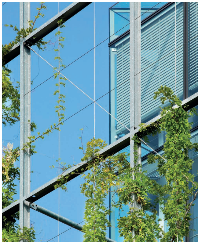
Abbildung 3: Rankhilfen Primär- und Sekundärkonstruktion
