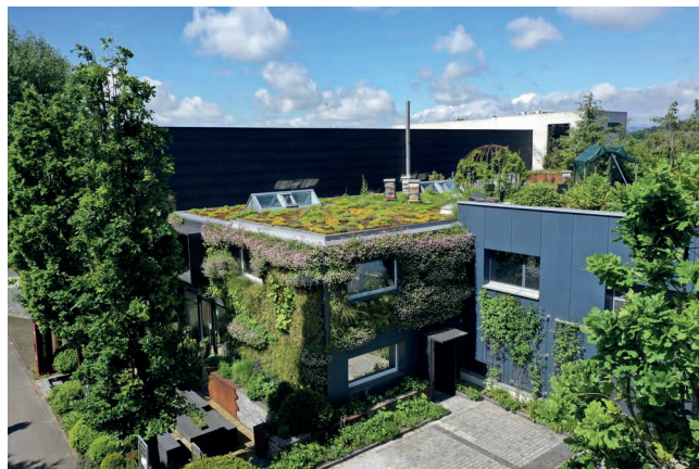
Abbildung 4: Gebäudebegrünungen im Überblick
