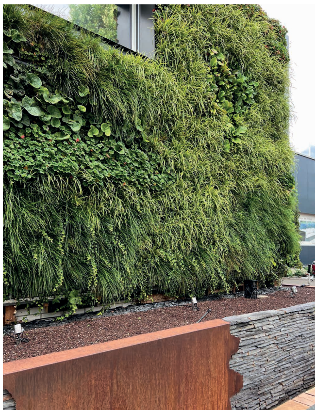
Abbildung 3: Wandgebundene Begrünung, System Biomura
