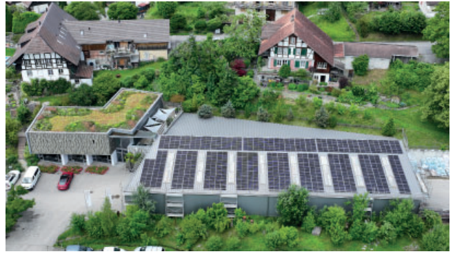
Abbildung 8: Bürogebäude und Werkhof mit neuer PV-Anlage
