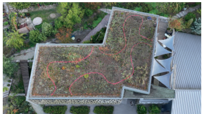
Abbildung 4: : Ausgangslage (bestehende Dachbegrünung)
