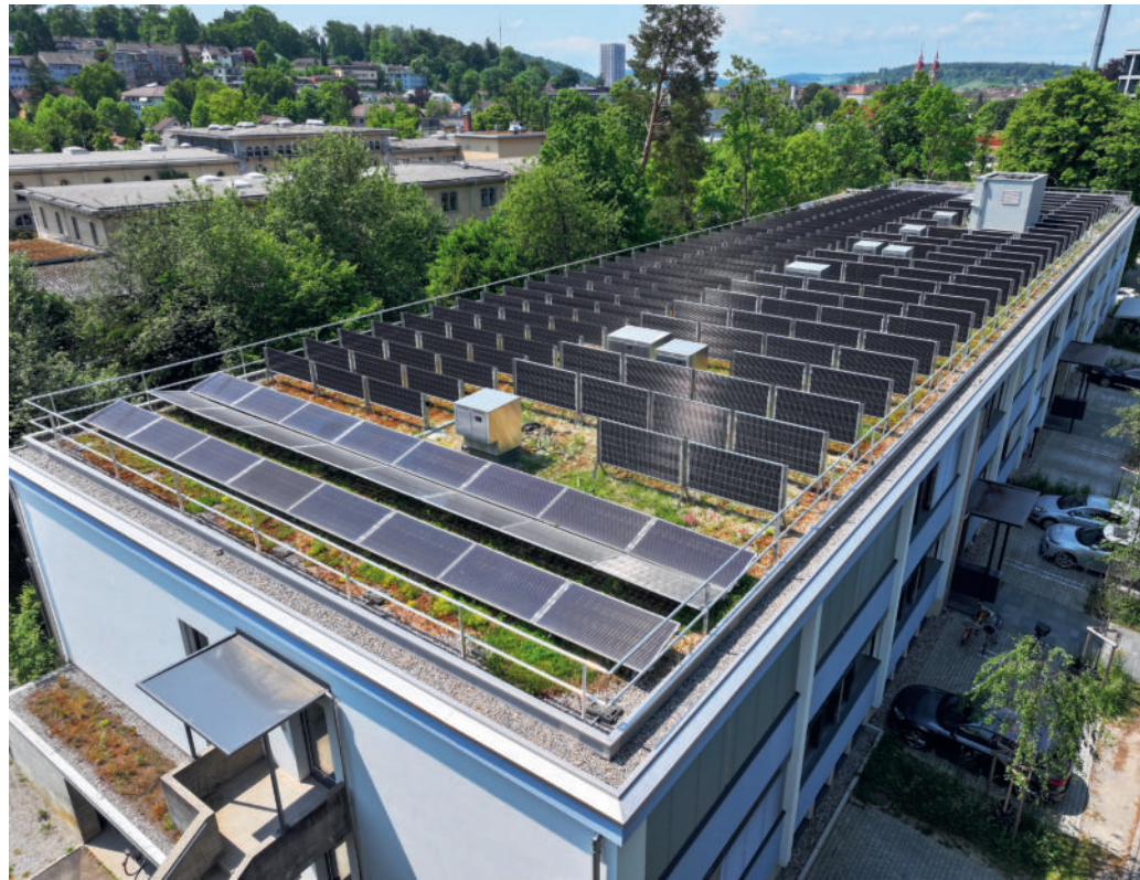
Bild 4: Auf dem Dach des Projekts «Mattenbach (Winterthur)» sind alle drei Nutzungen (Begrünung, Solar und Evapotranspiration) vereint.
