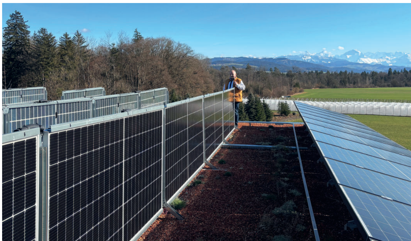
Bild 5: Auf einem EnergieGründach in Belp erläuterte Christoph Harlacher die Vorteile der kombinierten Ost/West- und Bifazial-Aufständerung.
