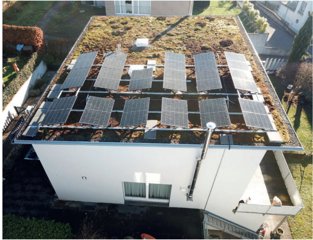
Bild 2a (links): Das Aufständersystem «Contec.greenlight on top» wurde speziell für die Nachrüstung von Solaranlagen auf bestehenden Gründächern entwickelt.
