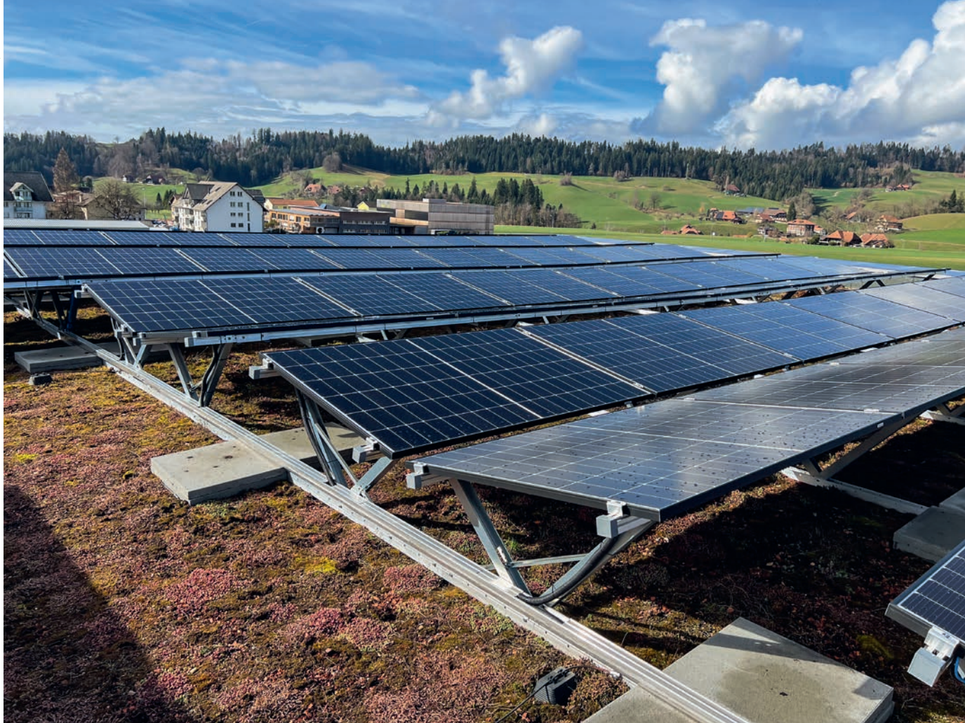
Die Nachrüstung von Dächern mit Photovoltaikanlagen bietet ein grosses Potenzial. Dies ist auch dort möglich, wo Gründächer aufgrund der örtlichen Baugesetze bei der Erstellung des Gebäudes vorgeschrieben wurden.
