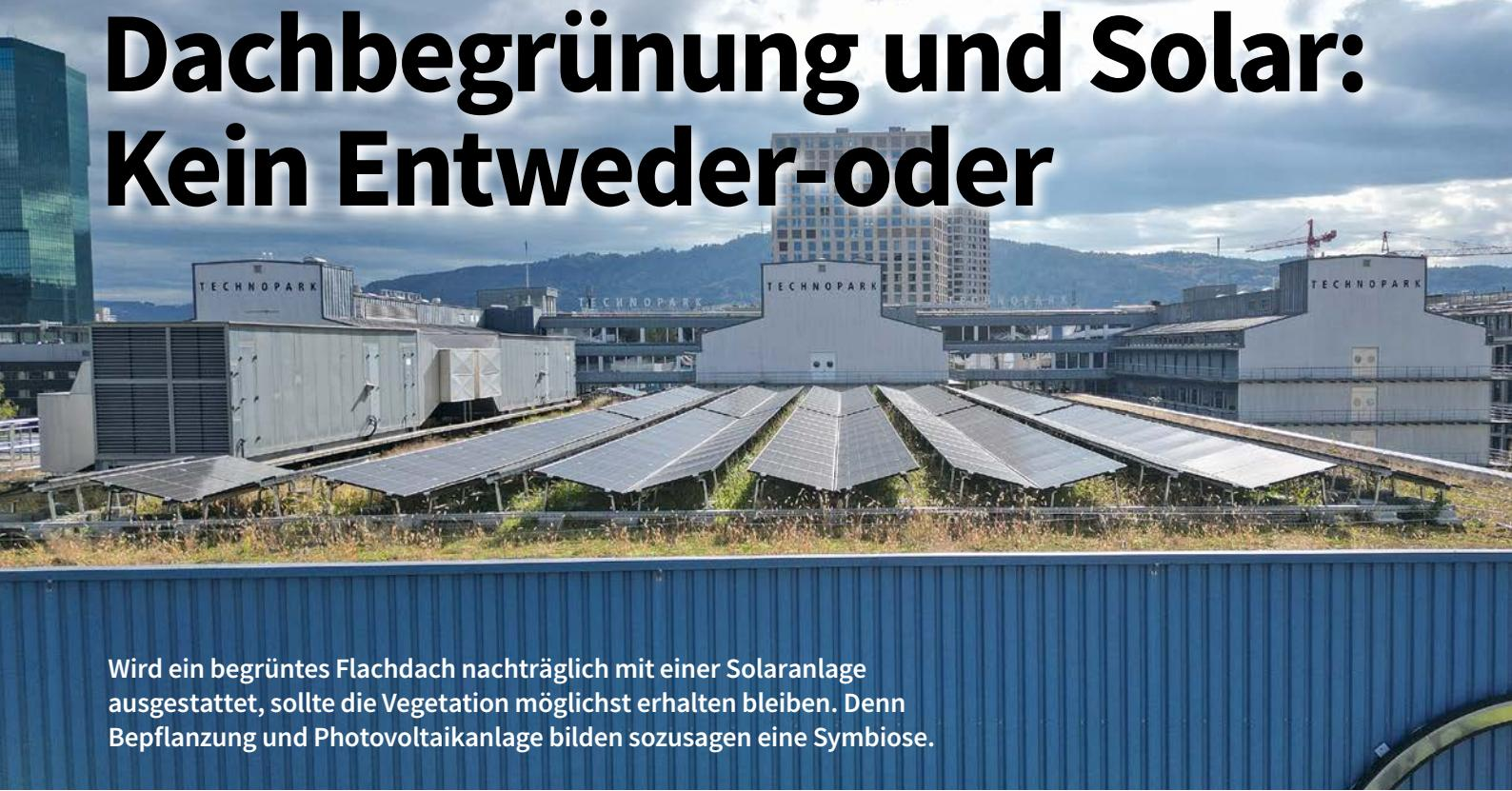
Wird ein begrüntes Flachdach nachträglich mit einer Solaranlage ausgestattet, sollte die Vegetation möglichst erhalten bleiben. Denn Bepflanzung und Photovoltaikanlage bilden sozusagen eine Symbiose.
