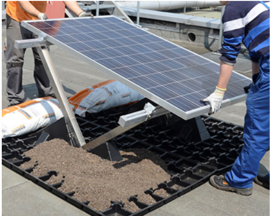
Abbildung 6: Auflastsystem für PV-Aufständerung, Quelle: Bauder
