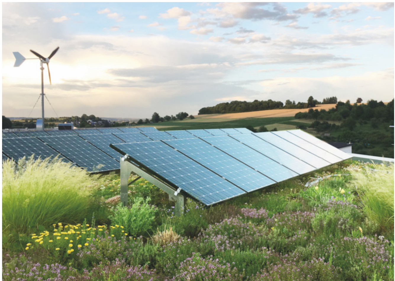
Abbildung 10: Kombination Intensiv-/Extensiv-Dachbegrünung neben PV-Anlage, Quelle: Zinco
