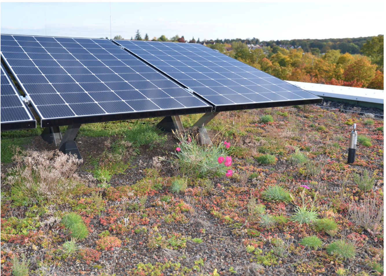
Abbildung 21: Absturzsicherung, Quelle: contec
