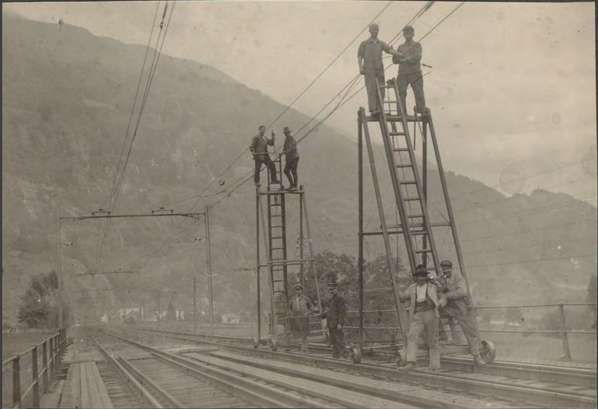
Elektrifizierung der Gotthard: Strecke Faido–Lavorgo, Bahnarbeiter bei der Installation von Fahrleitungen, ca. 1923 , SBB Kreisdirektion II
