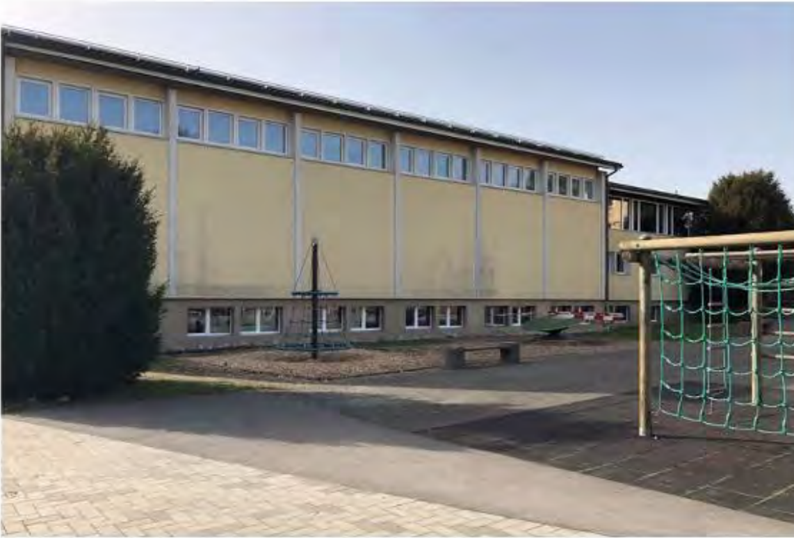
Ostfassade des alten Schulhauses Allmend (LU)
