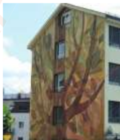
Abbildung 2: Giebelfassade vor Sanierung (Baujahr 1965)
