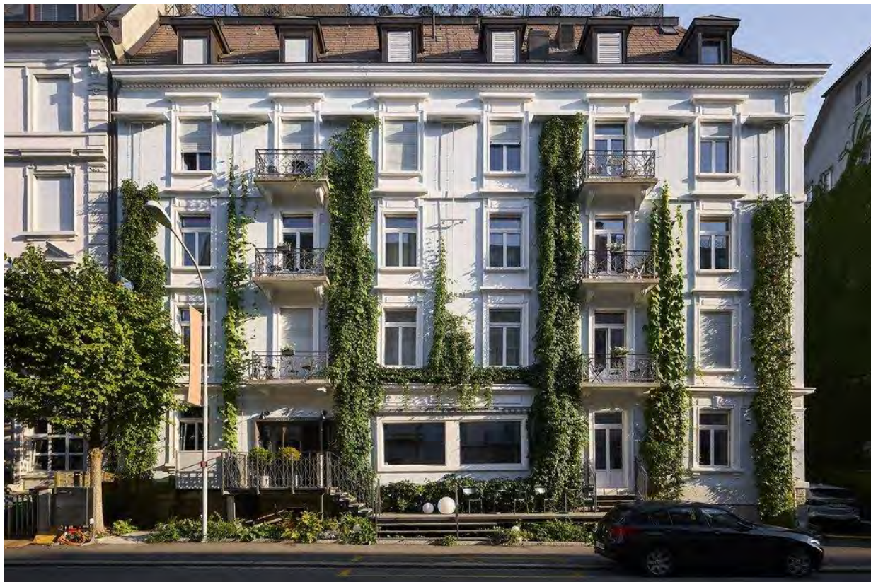
Abbildung 8: Fassadenbegrünung (Quelle: https://www.jakob.com/de/de/referenzen/gruene-fassade-mit-integriertem-brandschutz ).
