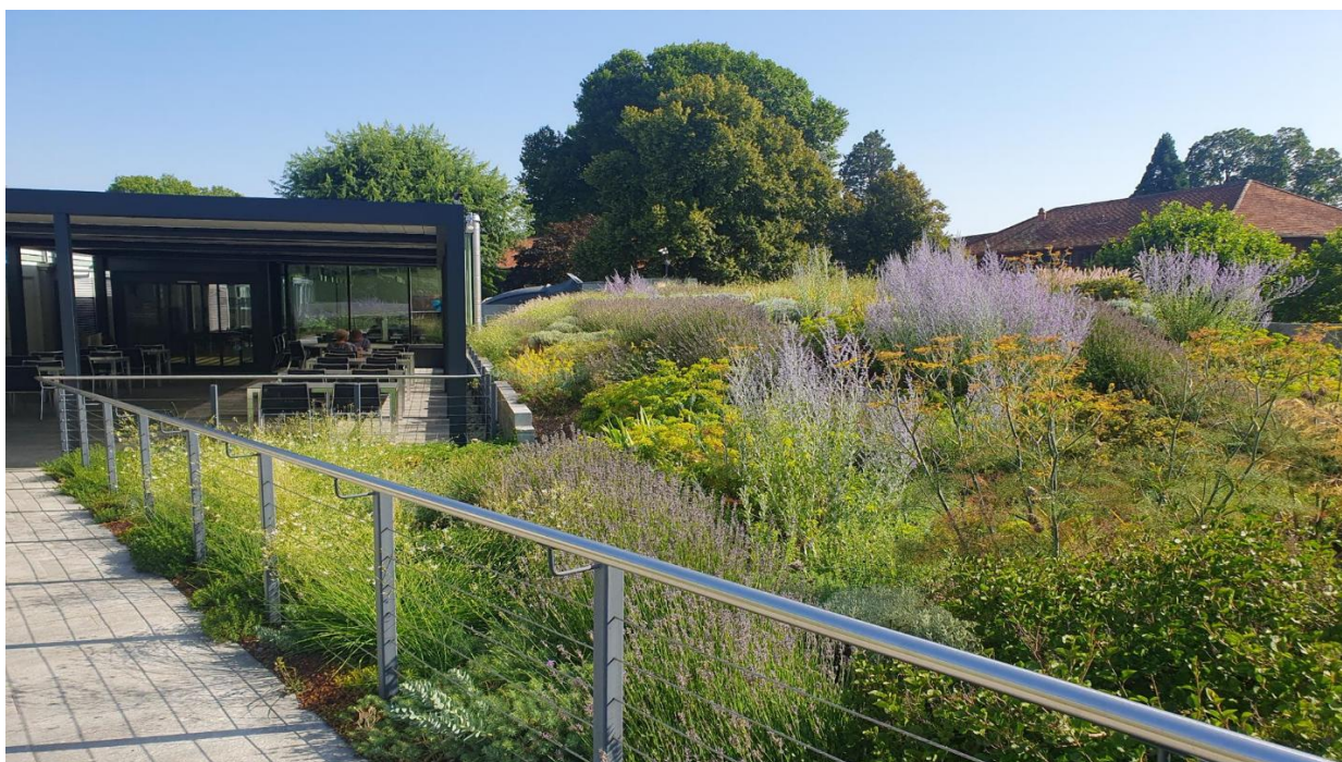
Abbildung 2: Intensive Dachbegrünung im Eingangsbereich des Restaurants der Aqua Arena Schinznach Bad (Photo Erich Steiner).
