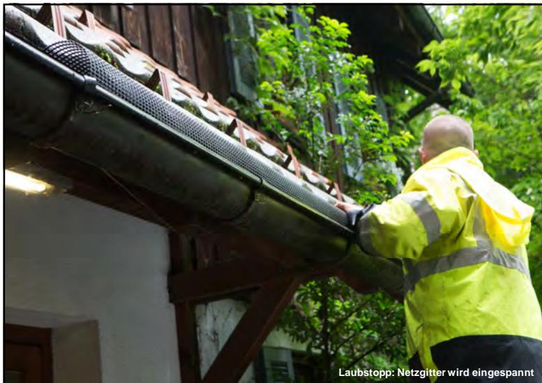
Laubstopp: Netzgitter wird eingespannt
